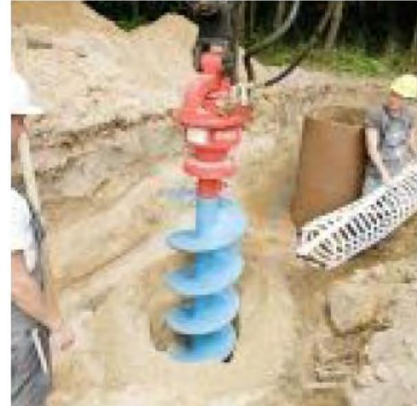
Die RAUGEO Helix PE-Xa ist eine spiralförmige Kurzsonde für den Tiefenbereich von 3-5 m, die insbesondere bei Objekten mit wenig Grundstücksfläche und/oder Bohrtiefenbeschränkung zum Einsatz kommt.
